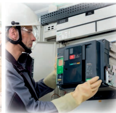
✓ Осветительные сети, вторичные цепи постоянного и переменного тока
