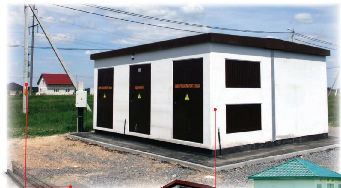
Закрытые трансформаторные подстанции с габаритными размерами от 4,8х5,0 м до 7,2х7,8 м
