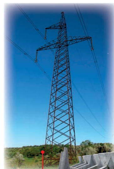
Железобетонные фундаменты для металлических опор ВЛ 35-500 кВ
